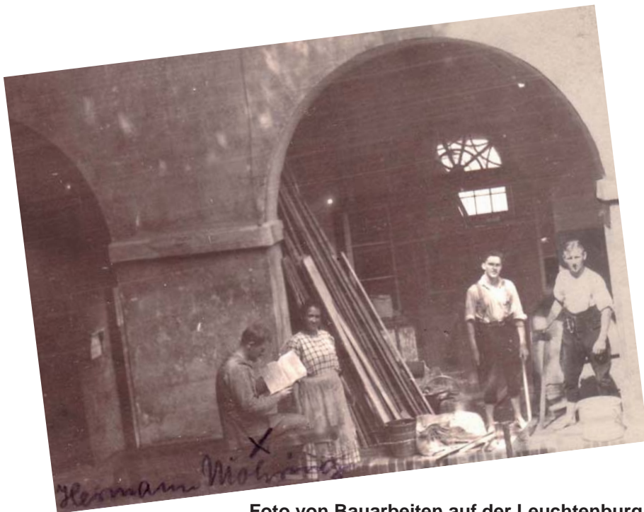
Foto von Bauarbeiten auf der Leuchtenburg, bei der die Flaschenpost versteckt wurde. Das Ehepaar links sind die Eltern von Dr. Wolfgang Möhring (1925-2011).
