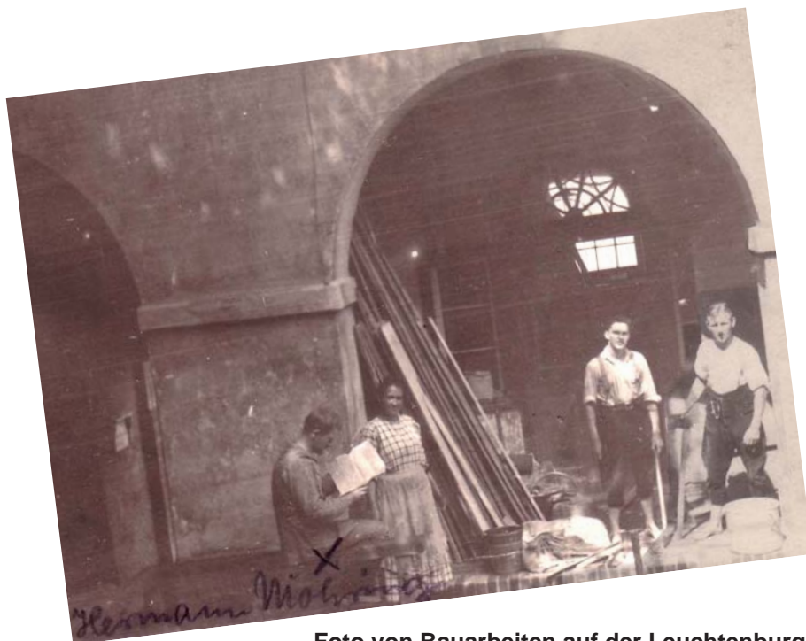
Foto von Bauarbeiten auf der Leuchtenburg, bei der die Flaschenpost versteckt wurde. Das Ehepaar links sind die Eltern von Dr. Wolfgang Möhring (1925-2011).
